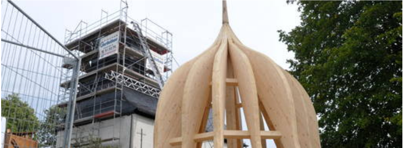
Teil der neuen Turmkuppel für die Kirche in Schweinbach. Foto: Klaus Moritz
